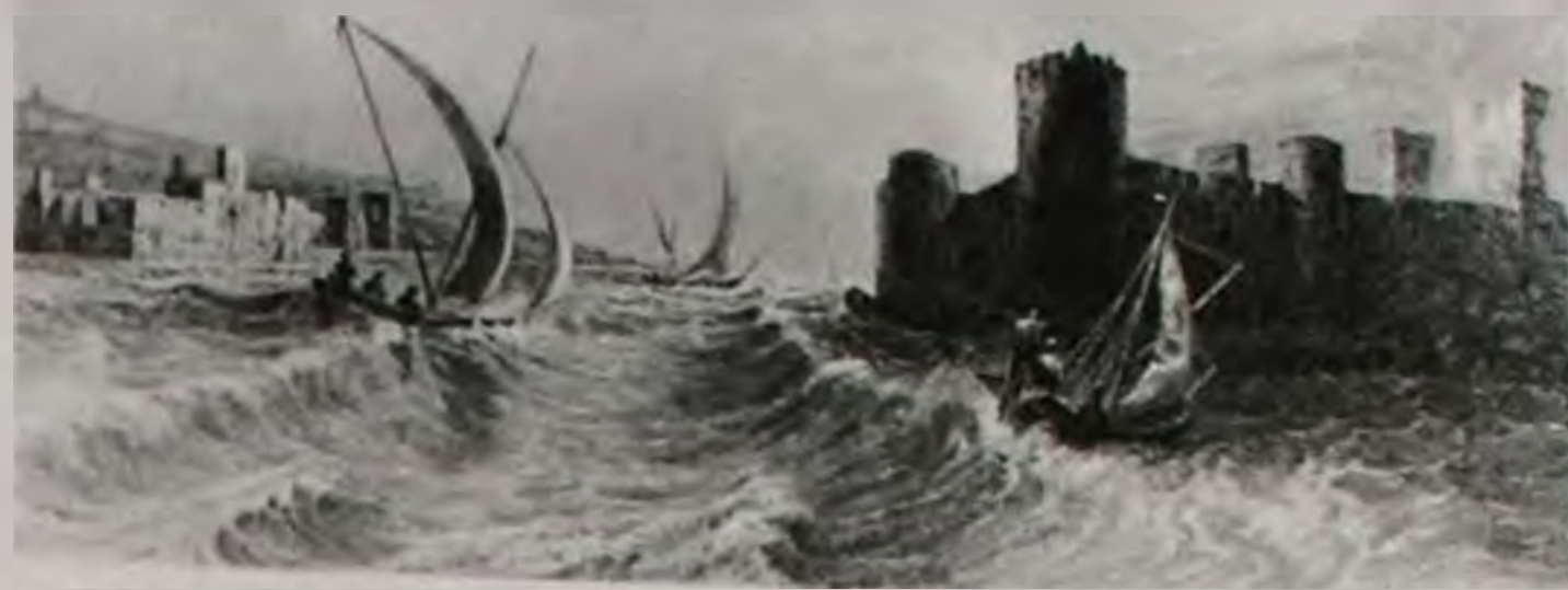
Les deux châteaux de Korikos (Gorhigos). Au loin, celui « de la terre », appelé Pambouk par les Turcs, construit sur le rivage par les Byzantins avant le XI e siècle ; au premier plan, Korikos « de la mer », bâti sur un îlot par les rois héthoumides. Toujours dévolu à l'un des grands barons du royaume d'Arménie, le fief de Korikos appartenait, à la fin du XIII e siècle, au seigneur Vakhran, le troisième époux d'Alix, fille du baron Rupen et d'une française, Isabelle de Thoron, dame des châteaux de Krak et de Montréal en Terre Sainte.
