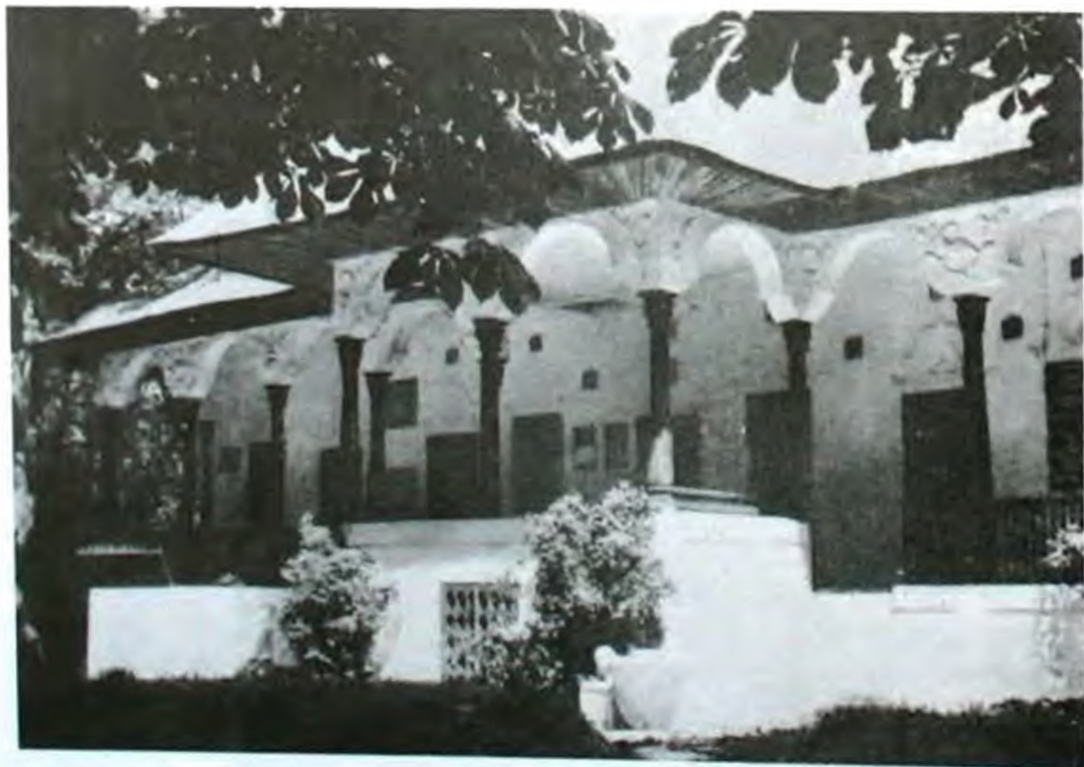
Le manoir des barons Bellio, sur leur domaine de Urlatzi, en Valachie. La construction est l'œuvre d'artisans amenés de Macédoine.
